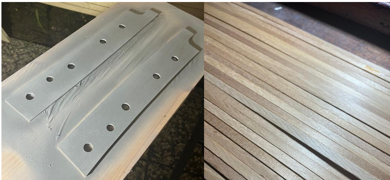
Hytin alakannen sivut pohjamaalauksessa ja kansitikut oikeenmassa
